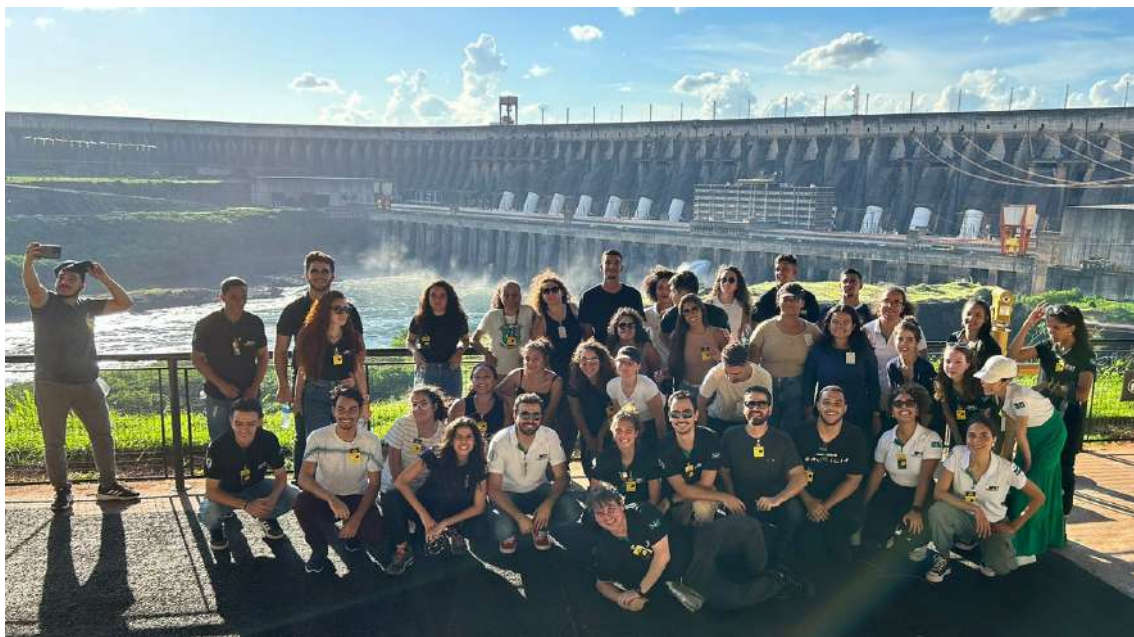
Figura 18.1: Foto registrada durante visita técnica à Usina Hidrelétrica de Itaipu, organizada pelo PET Engenharia Civil, com a participação de alunos do Departamento de Engenharia Civil e Ambiental da UnB.
